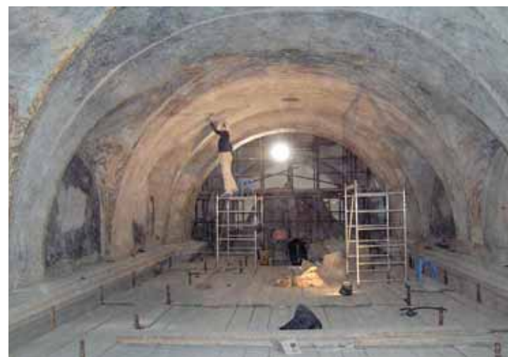
La volta della basilica antica durante i lavori di restauro.
