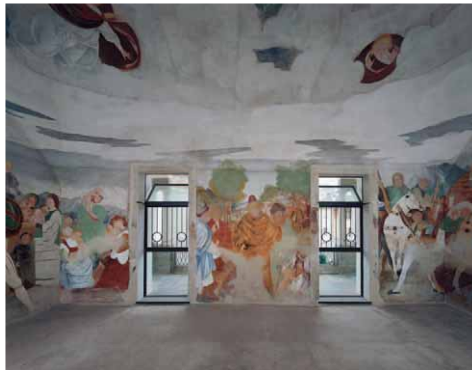
4. Cappella della Crocifissione , la parete ovest con le due aperture ottocentesche chiuse dalle porte con "vasistos" progettate dall'Istituto Centrale per il Restauro
