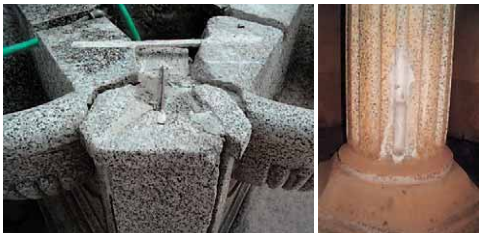
5. Dettaglio con i perni di acciaio che tengono insieme le facce verticali del basamento, affogati in resina epossidica
