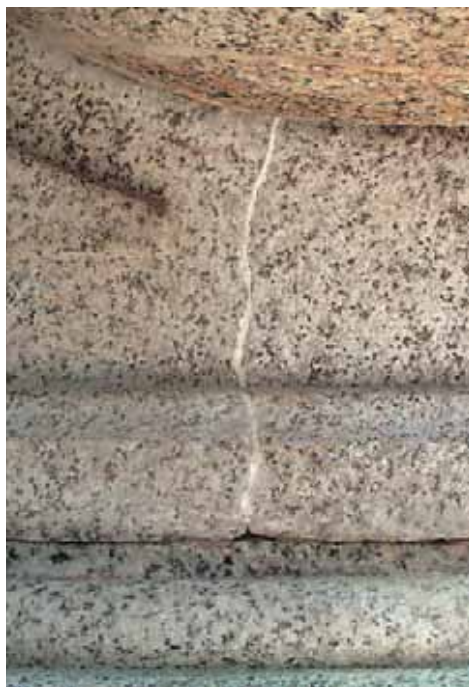
8. Sigillatura della faccia fratturata del basamento
