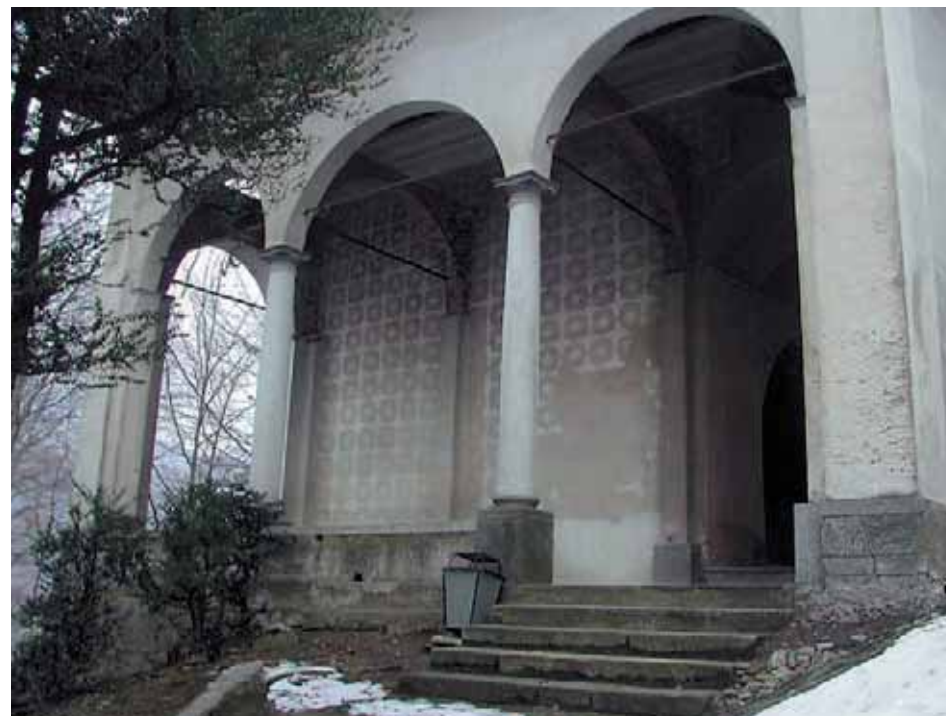
10. Veduta d'insieme della facciata, dopo il restauro
