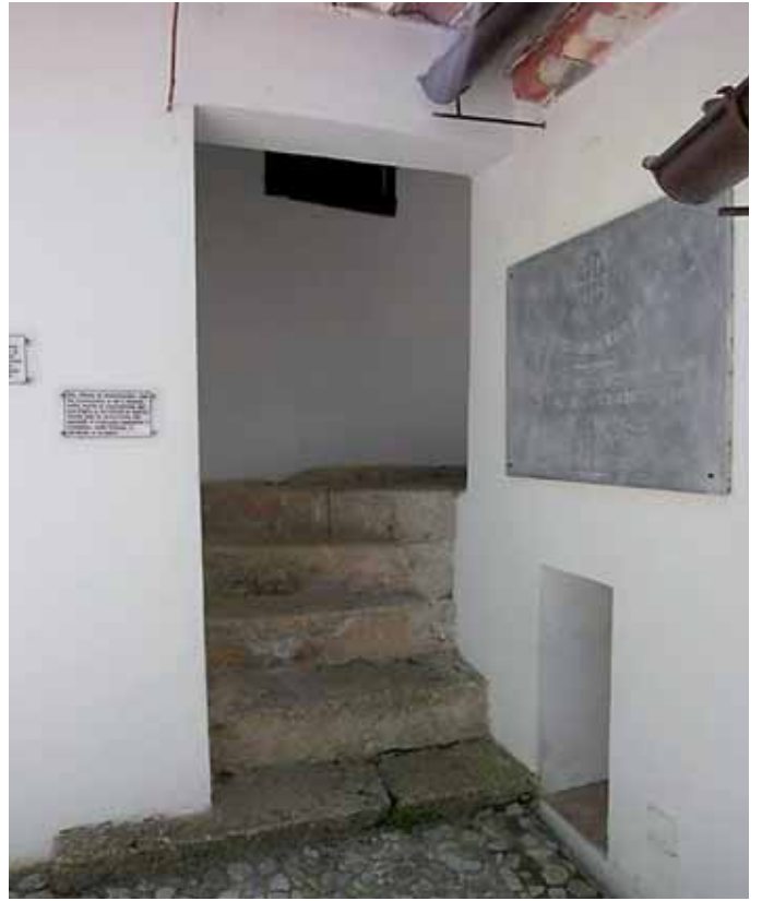
Fig. 10. Laino Borgo, Santuario delle Cappelle . La rampa di scala che conduce alla Cappella della Buca della Croce ha i gradini scavati direttamente nella roccia.
