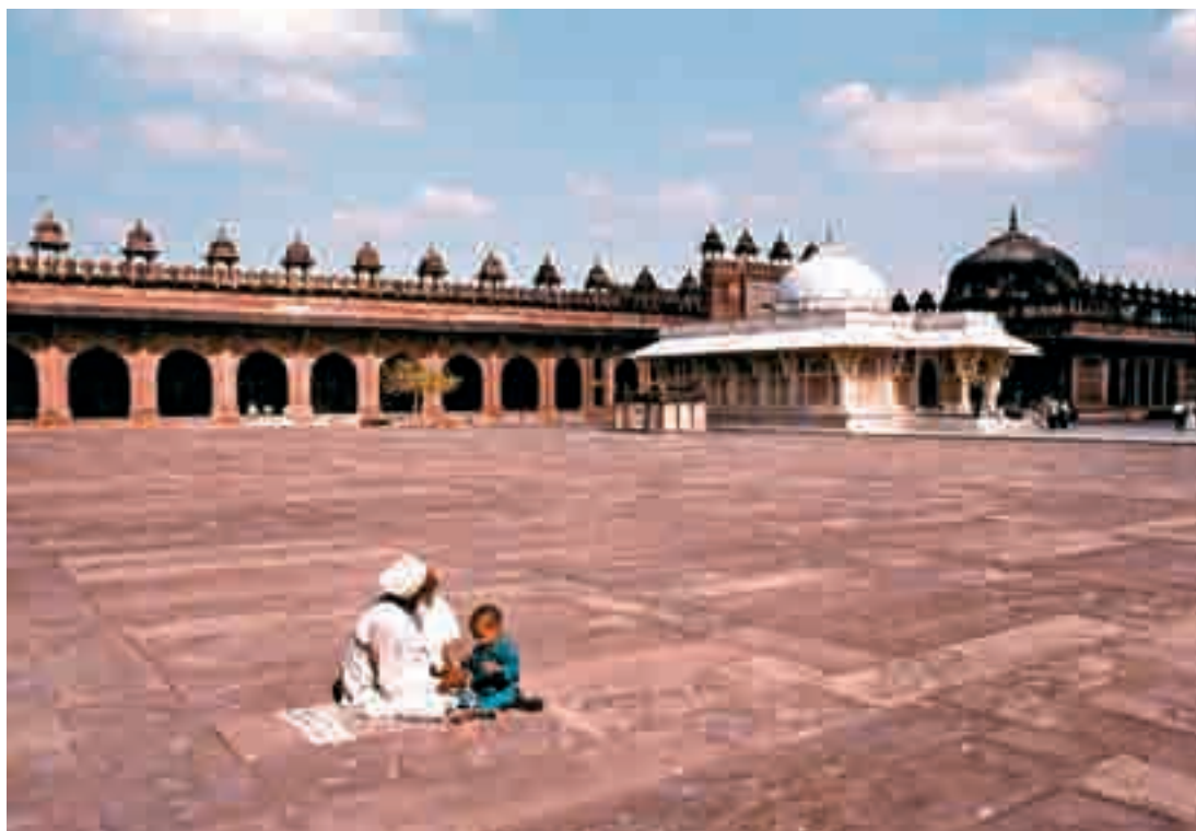
2. L'angolo nord-occidentale della corte della moschea principale (jāmā-masjid) di Fatehpur Sikrī, con la tomba a cupola di Šekh Cīstī (S. Piano).
