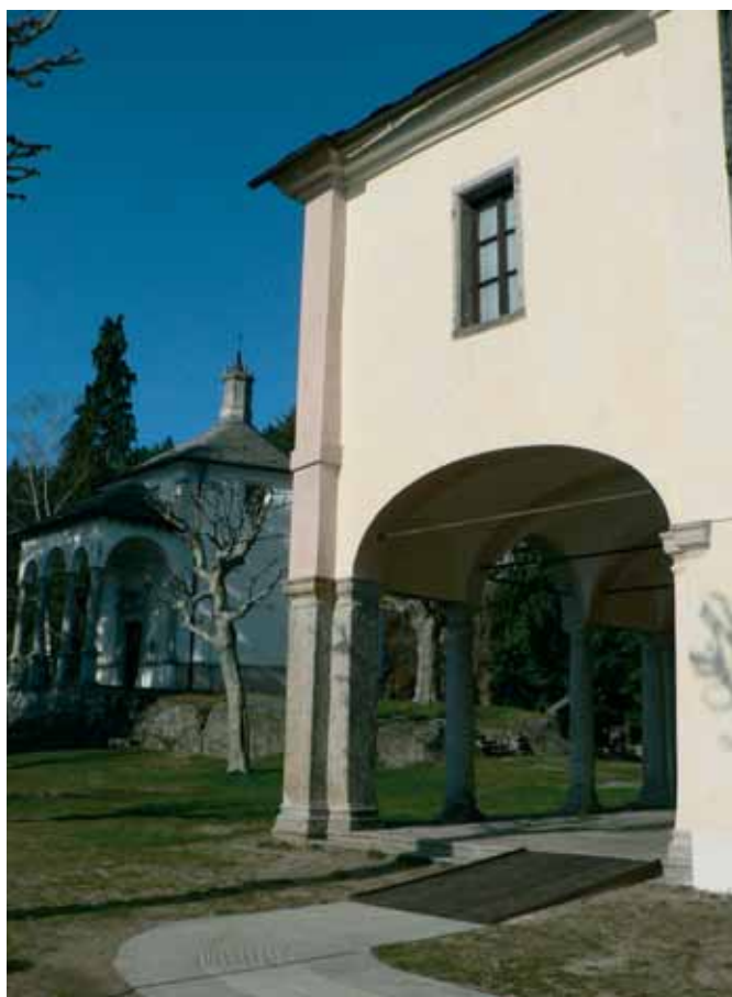
Fig. 58. Ghiffa, SS. Trinità, il portico e il locale soprastante.
